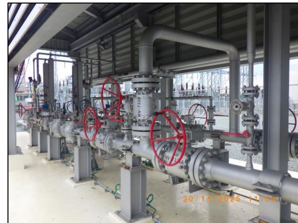
รูปที่ 2.42 ระบบท่อ By Pass และระบบวาล์วสำรอง
