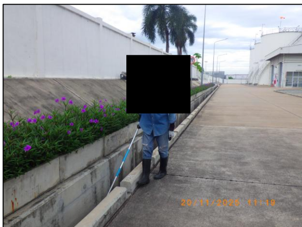
รูปที่ 2.22 การทำความสะอาดรางระบายน้ำ และท่อระบายน้ำ
