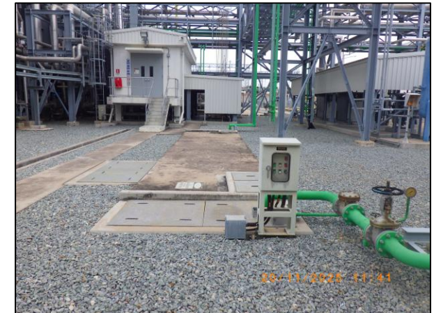
รูปที่ 2.9 บ่อแยกน้ำมัน (Oil Separator)
