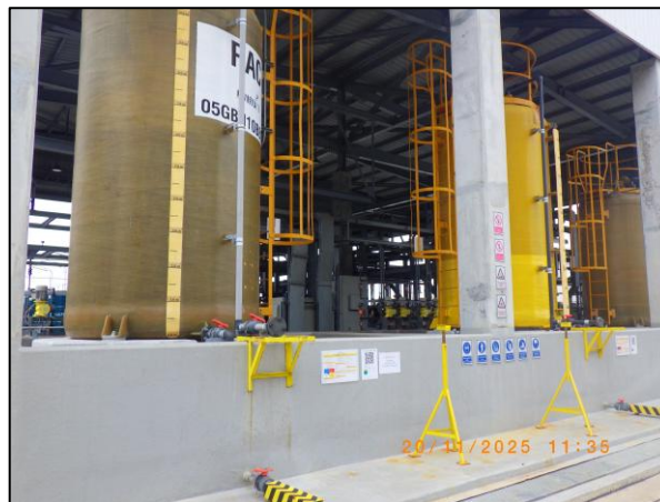
รูปที่ 2.37 คันคอนกรีตรอบถังเก็บสารเคมี
