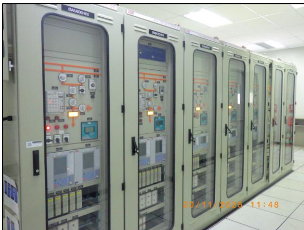
รูปที่ 2.45 ระบบป้องกันทางไฟฟ้า (Transformer Protection)
