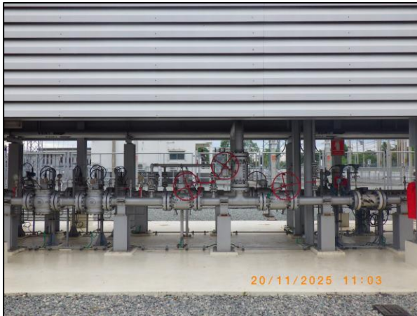
รูปที่ 2.42 ระบบท่อ By Pass และระบบวาล์วสำรอง (ต่อ)
