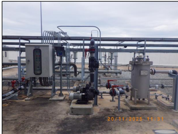
รูปที่ 2.7 บ่อปรับสภาพความเป็นกรด-ด่าง (Neutralization Pit)
