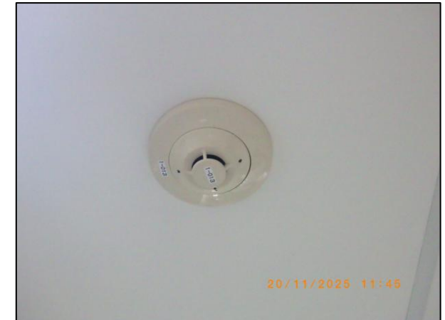
รูปที่ 2.32 ระบบตรวจสอบ ตรวจจับ และสัญญาณเตือนภัย
